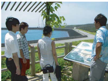
沖縄県 やんばる海水揚水発電所
