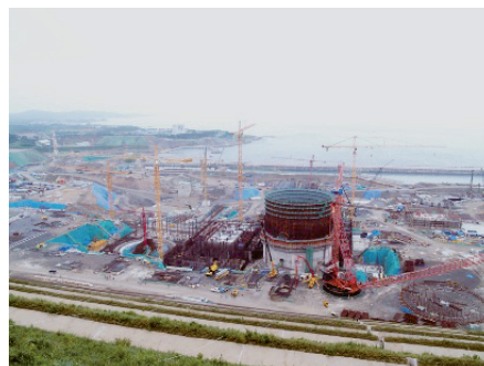
写真6 建設中のShin-KORI炉
